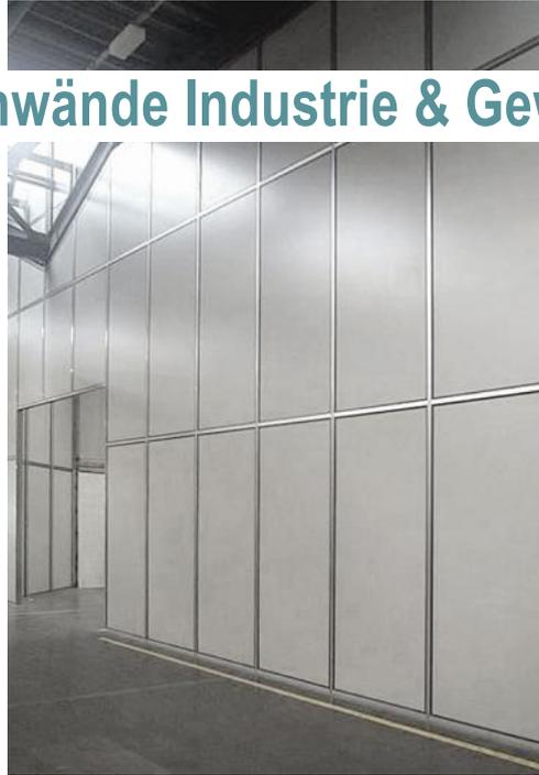
Die Aluminium-Profile sind wahlweise eloxiert - was äusserste Kratz- und Widerstands-Festigkeit bedeutet oder pulverbeschichtet Farbe nach Wunsch.
